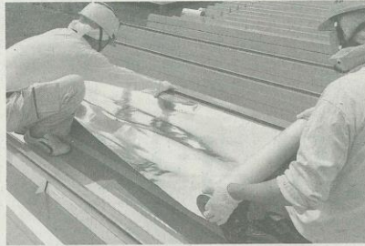
工場や店舗で一般的な折板屋根にアルミシートを両面テープで貼り付ける
