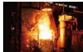
産業用機械・電気炉・集塵機
