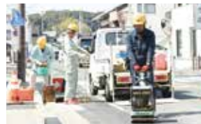
上下水道工事
