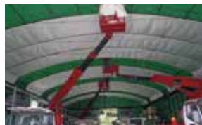
工場営繕工事
