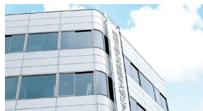
内外装金属パネル工事
