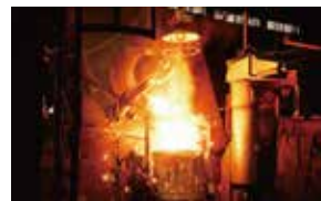
産業用機械・電気炉・集塵機
