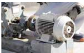
ポンプ(修理・交換)
