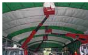
工場管繕工事
