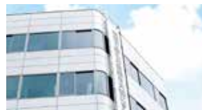
内外装金属パネル工事
