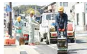
上下水道工事
