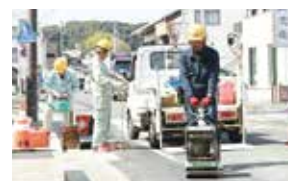
上下水道工事
