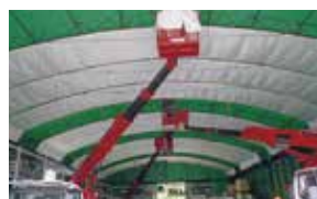
工場管繕工事
