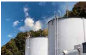
本社 オイルターミナル （災害時対応型油槽所）
