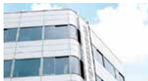
内外装金属パネル工事
