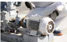
ポンプ (修理・交換)
